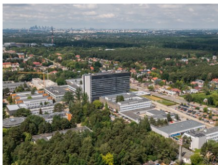
Widok na IPCZD z lotu ptaka Źródło: Łukasz Widziszowski /WOŚP
